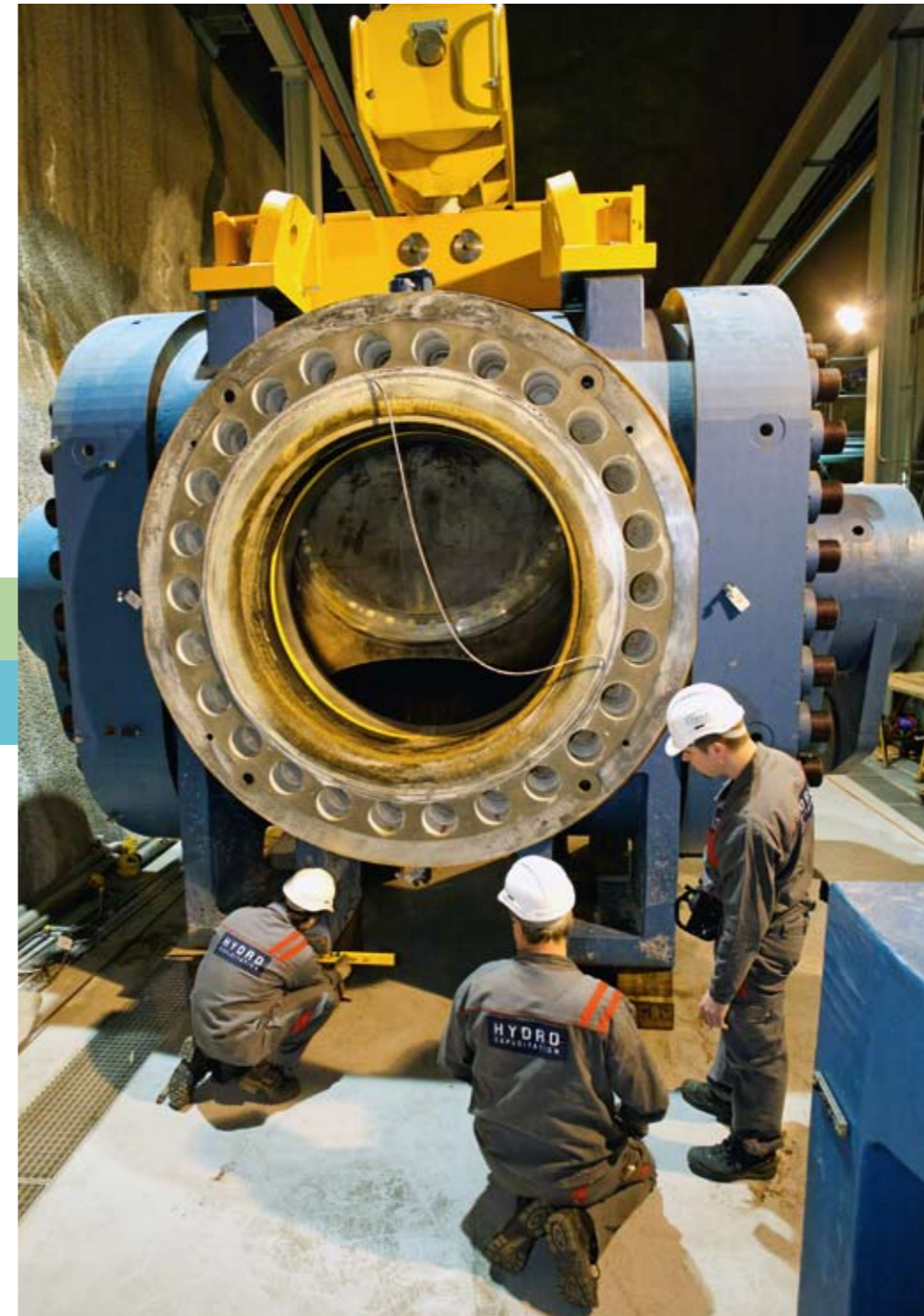
Montage d'une vanne sphérique lors de la remise en service de la centrale de Bieudron.
