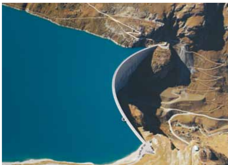
Le barrage de Moiry Das Stauwerk Moiry
