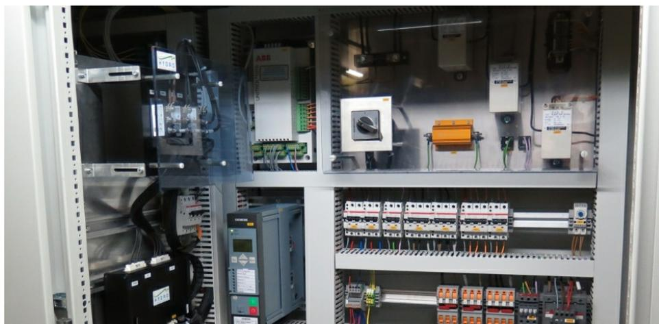
Il surveille le point de fonctionnement de la machine et le maintient dans les limites admissibles. C'est donc un élément important du groupe hydroélectrique.
